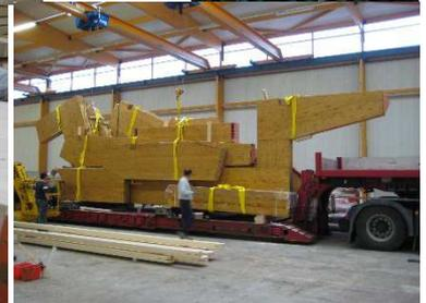
assurant une excellente rigidité. Les boomerangs préassemblés en atelier sont livrés avec des ferrures à chaque extrémité, prêts à poser sur chantier.
