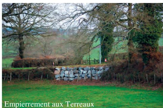
La consolidation de la **chaussée de la voie communale n° 21 au lieu-dit "Les Terreaux"** (Route des Bruyères) a été réalisée par l'entreprise JAYET pour un montant de 3 450 € H.T. Elle a consisté en des travaux d'enrochement dans le virage de cette route car la chaussée avait tendance à s'affaisser.
