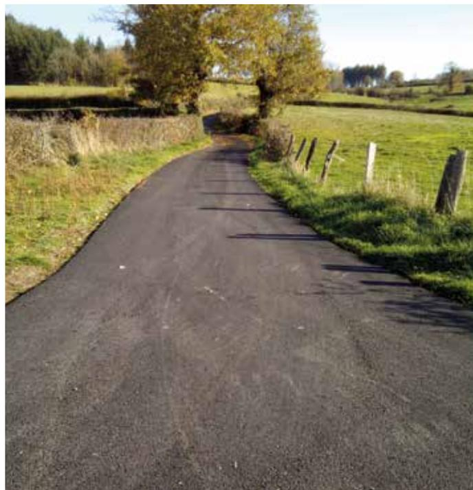
**Route de LA CROIX DES DUCS (La Hyène) :** Goudronnage à chaud pleine largeur sur une longueur de 105 ml, reprofilage à chaud puis enduit monocouche sur 411 ml.
